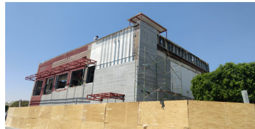
KFC rehabilitacion de fachada en proceso
