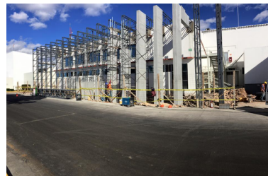
Fachada de planta Bachocco en proceso de obra, dic 2007
